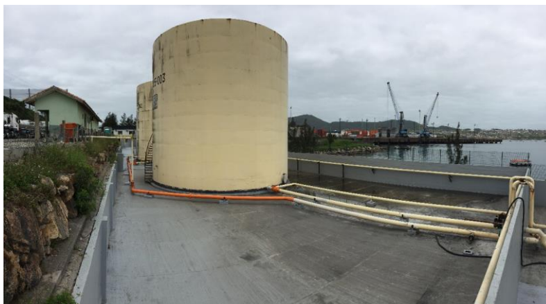
Figura 11: Tanques 02 e 03 na área IMB05 desativados Fonte: SCPAr
