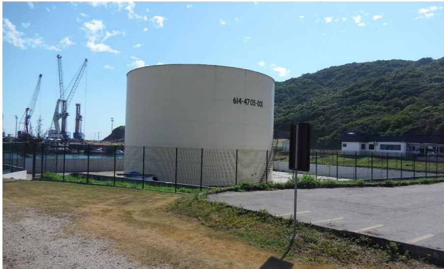
Figura 10: Tanque 01 na área IMB05 disponível para operação Fonte: SCPAr
