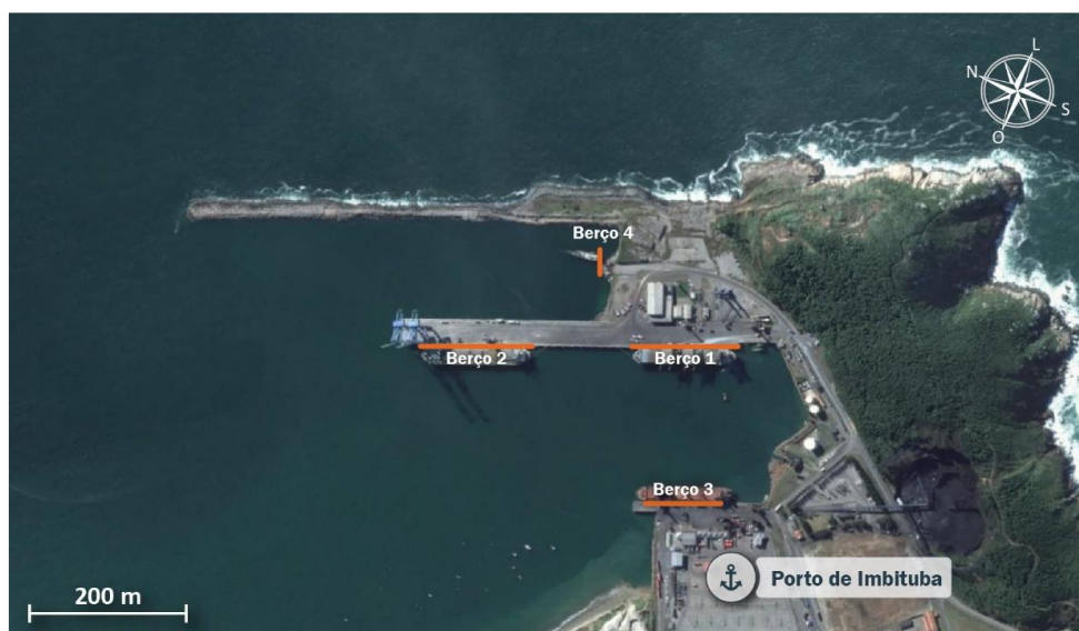
Figura 02 – Infraestrutura de Acostagem do Porto de Imbituba Fonte: Plano Mestre do Complexo Portuário de Imbituba (2018)
