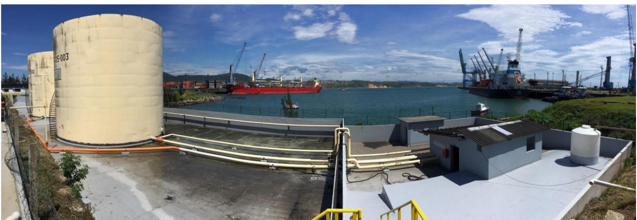
Figura 12: Tubulação indo da casa de bombas até a bacia 2 Fonte: EVTEA doado NCA - 2020
